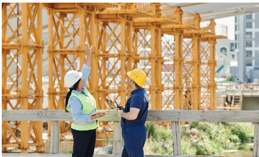
Delovanje v smeri ozaveščanja o trajnostnih gradbenih materialih
